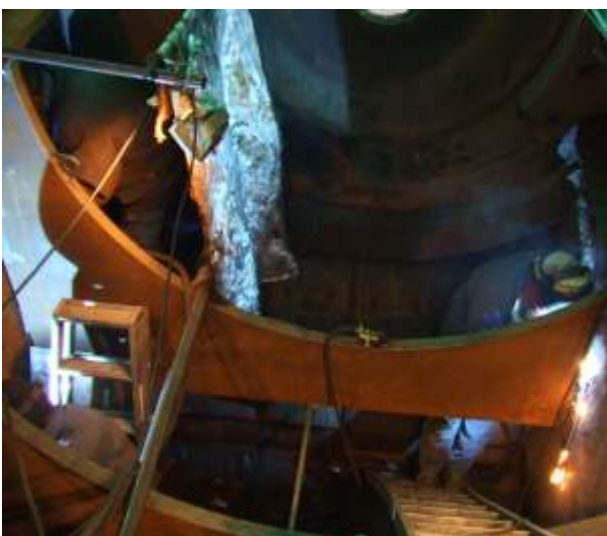
Während der Reparatur
