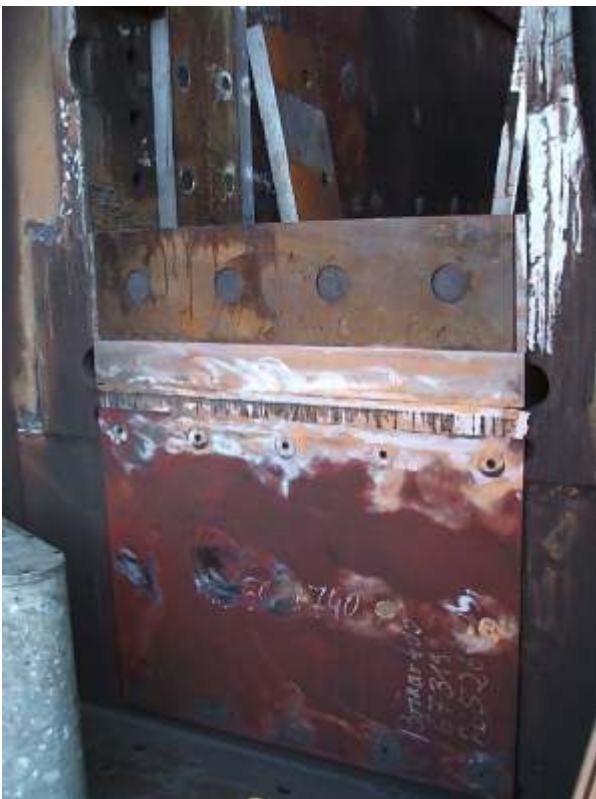
Ständer nach Instandsetzung
