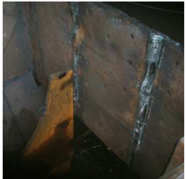
Während der Reparatur
