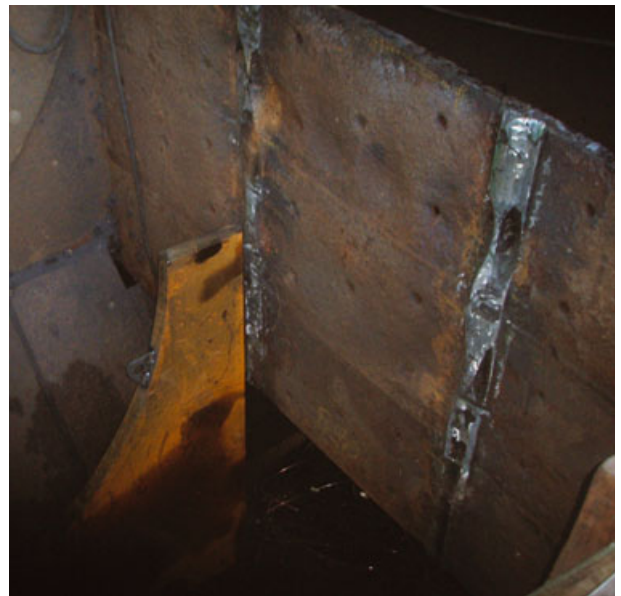
Während der Reparatur
