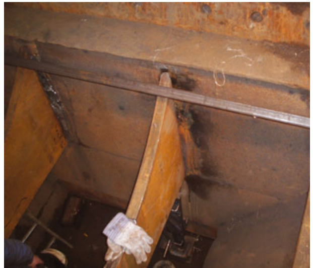
Nach der Reparatur
