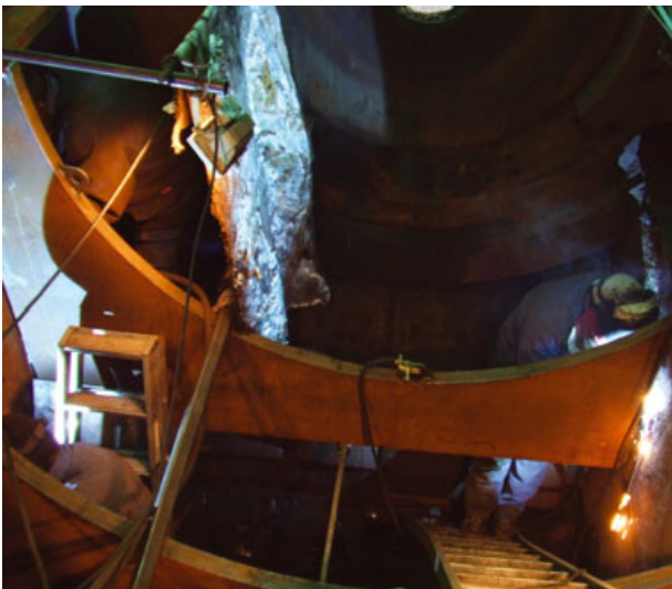
Während der Reparatur
